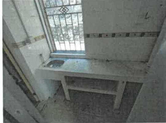
图片 12、估价对象 2 现状
