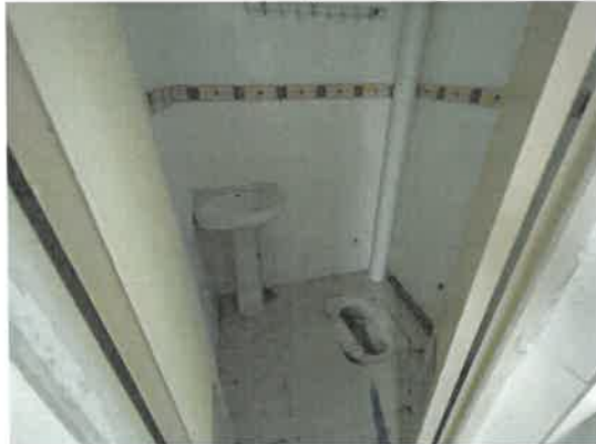
图片 13、估价对象 2 现状
