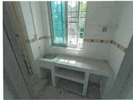
图片 6、估价对象 1 现状
