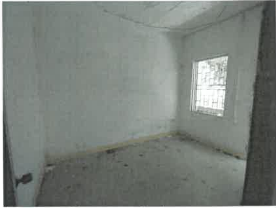
图片 10、估价对象 2 现状
