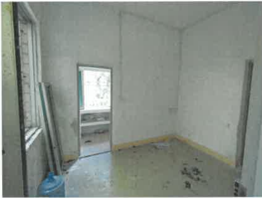
图片 9、估价对象 2 现状
