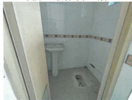
图片 7、估价对象 1 现状
