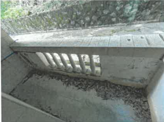
图片 11、估价对象 2 现状
