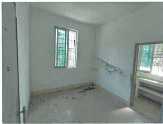
图片 3、估价对象 1 现状
