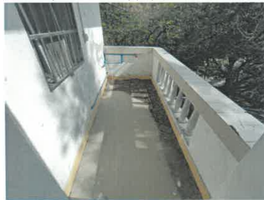
图片 5、估价对象 1 现状
